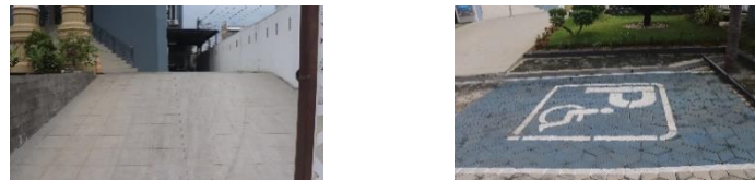
Gambar 10 Kenyamanan Hakiki pada gedung kantor Kejaksaan Negeri kota Lhokseumawe
