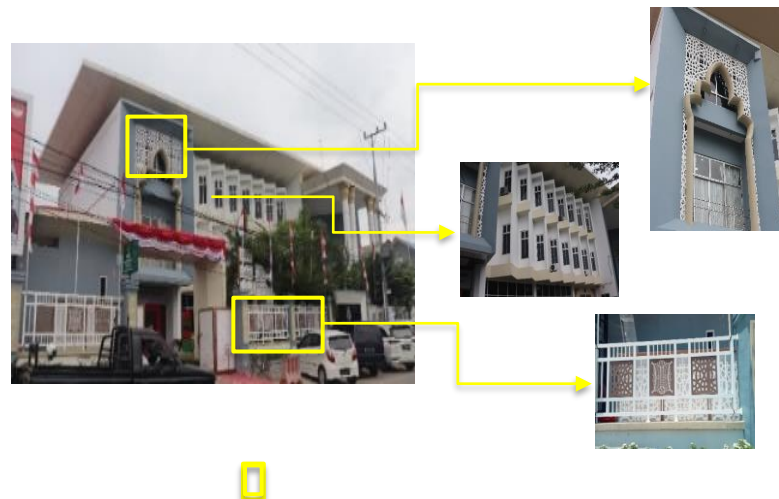
Gambar 2 Material fasad gedung kantor Kejaksaan Negeri kota Lhokseumawe
