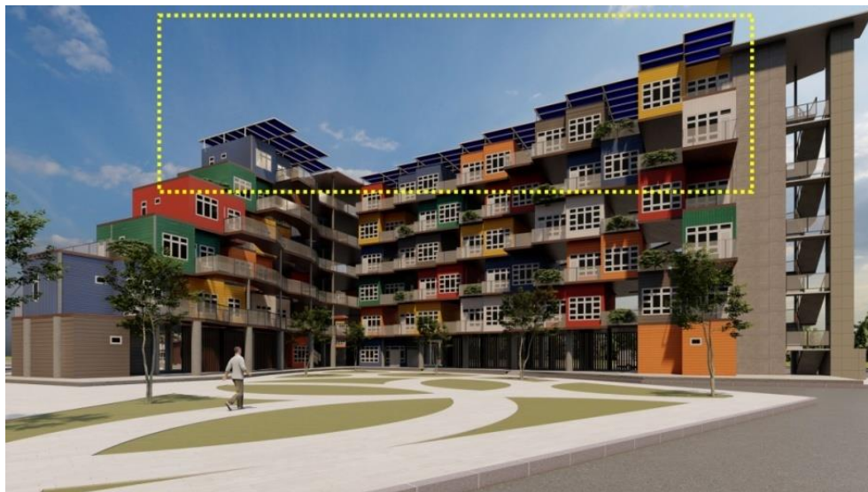
Gambar 13. Penerapan panel surya pada rumah susun reuse container
